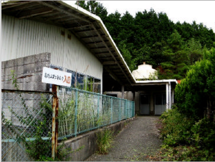
冷却塔があることから、厳冬の高野山でも天然リンクでないことがわかる。
